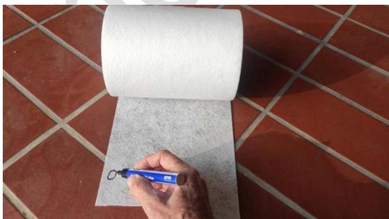
Das Gewebe hat eine **Ober-** und eine **Unterseite**. Sie sollten es so verwenden, wie sie es auf dem Boden ausrollen. Gegebenenfalls sollten Sie die Oberseite markieren, um ein Verdrehen auszuschließen.
