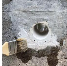
Auch Ecken und Übergänge wie zum Beispiel von der Bodenplatte zur Wand, an Treppenstufen oder anderen Stellen, an denen unterschiedliche Materialien oder Bauteile aufeinanderstoßen, sollten mit **TecnoFILL™** verspachtelt oder mit **TecnoSEAL™** ausgespritzt und sofort mit **TecnoSOLV™** glattgestrichen werden. Die zu überstreichenden Rahmen der Einbauteile sollten zur Verbesserung der Haftung angeschliffen und mit **TecnoSOLV™** gereinigt werden.
