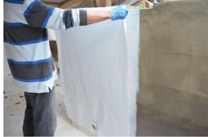
In den Bereichen der Überlappungen wird etwas mehr Material benötigt als in der Fläche. Um die dadurch entstehenden Unebenheiten auszugleichen, kann in den folgenden Schichten Zwei und Drei hierauf Rücksicht genommen, das Material entsprechend verteilt und die **Überlappung evtl. einmal extra überstrichen werden**.
